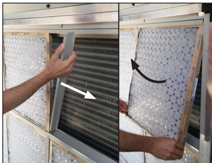
Figura 22 - Retirada dos filtros
