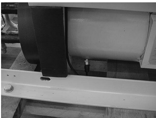
RT2 - Termistor de entrada de água gelada
