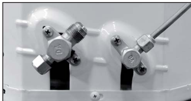
FIG. 27 - CONEXÃO DA LINHA DE EXPANSÃO DA UNIDADE CONDENSADORA
