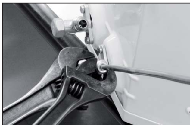
FIG. 26 - FIXAÇÃO DA PORCA
