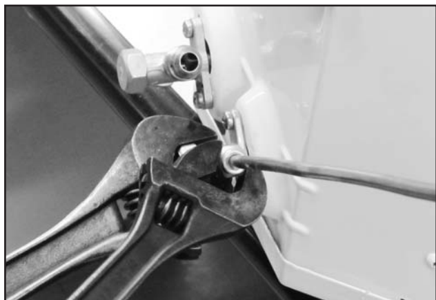
FIG. 38 - FIXAÇÃO DA PORCA
