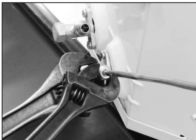
FIGURA 24 - FIXAÇÃO DA PORCA
